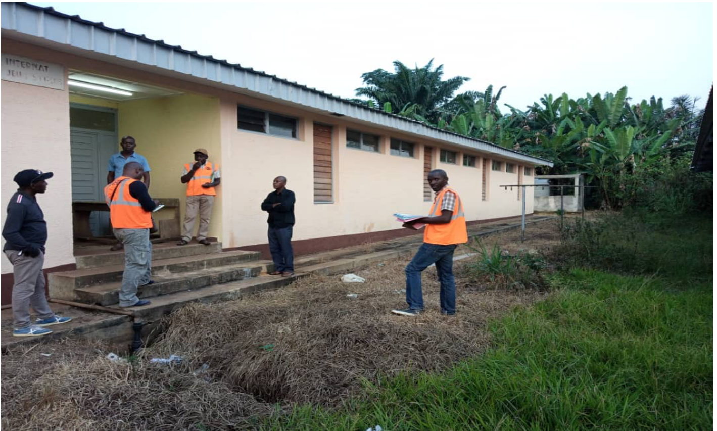
Photo : DGMP. Vue sur un internat réhabilité au Gabon, au cours d'une mission de contrôle effectuée par la DGMP en septembre 2022.
